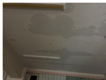
放送室の天井
