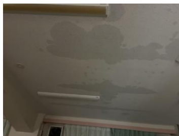
放送室の天井
