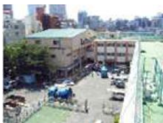
校舎・体育館棟耐震工事
